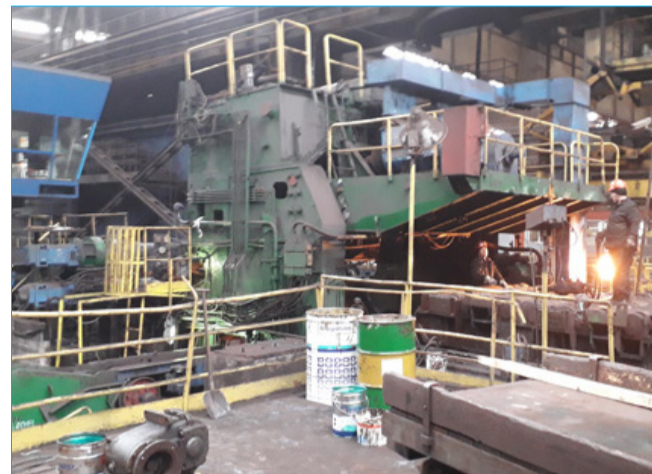
Remont linii cięcia w Walcowni Blach Grubych.
